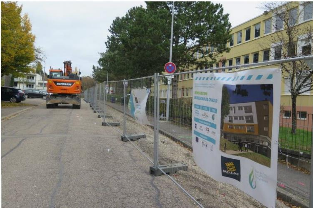
Les travaux commencent juste rue d'Anjou pour remplacer les conduites du chauffage urbain. Photo ER /François-Xavier GRIMAUD
