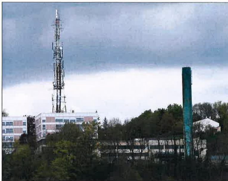
Le tarif du mégawattheure va passer de 125 € à 68,99 €, promet le futur délégataire du réseau de chaleur de la Côte. Photo ER/Jean-Noël PORTMANN
