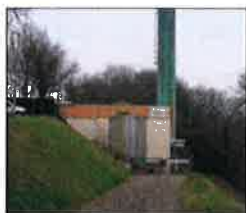
La chaufferie de la Côte Sainte-Catherine. Photo ER/François-Xavier GRIMAUD
