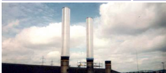
1997 : mise en place d'une turbine de cogénération et rehaussement des cheminées
