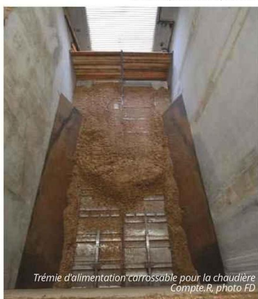
Système d'alimentation en bois de la chaudière Compte.R à trois compartiments, photo FD
